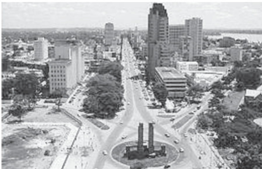
Der „Boulevard du 30 Juin“ vor den Arbeiten
