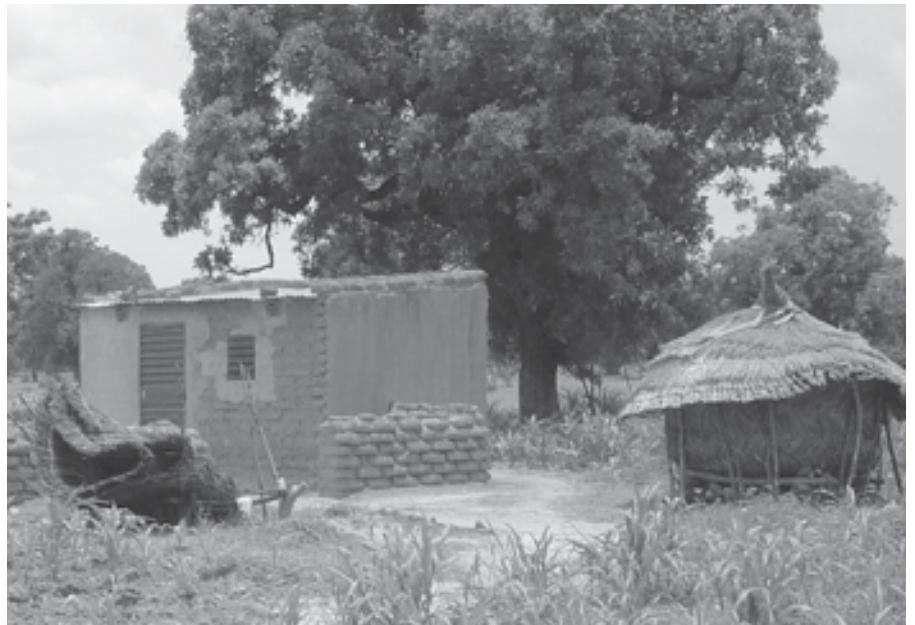
Bau eines Hauses
