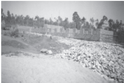
Neue Schulräume werden gebaut
